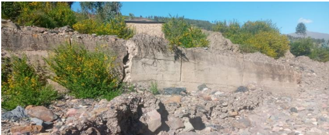
FIGURA N°02: : Se Aprecia el muro de contension afectado por la presencia de las avenidas ordinarias periodo 2021-2022, cauce colmatado.
